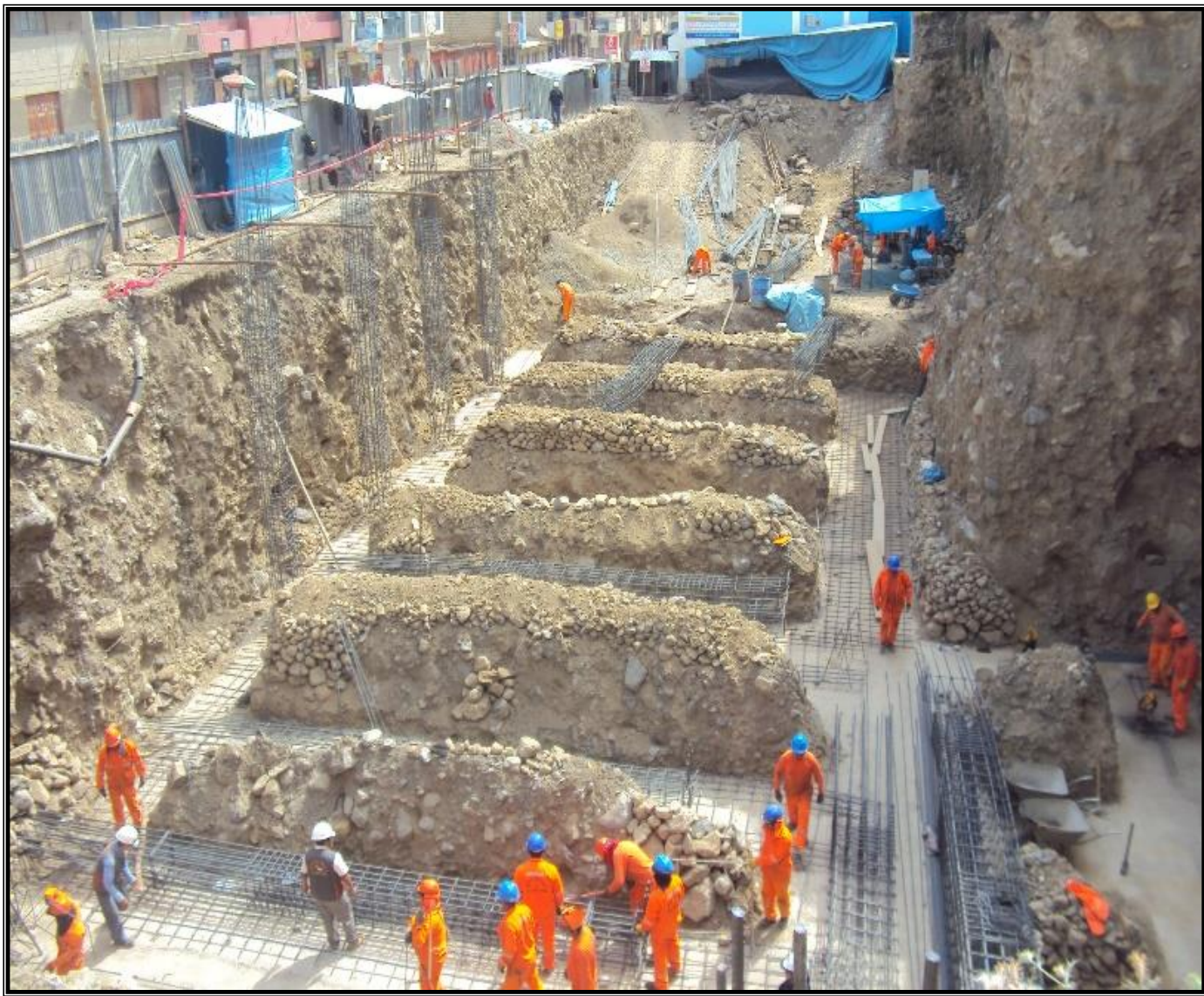
▶ VISTA DE ARMADO DE COLUMNAS.
